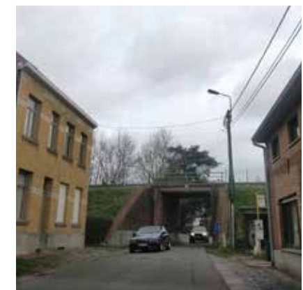
Croisement dénivelé de la Savooistraat avec la voie ferrée.
