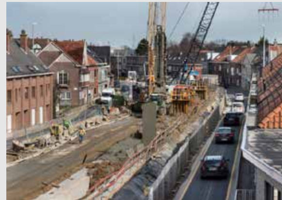
Tunnel en fouille à ciel ouvert à travers un noyau pendant la phase de construction, R41, Alost.
