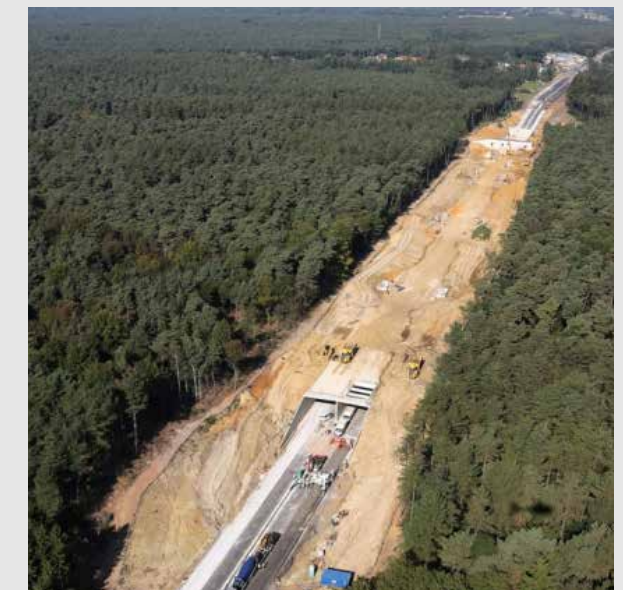
Impact du tunnel en fouille à ciel ouvert sur la nature pendant la phase de construction, Tunnel Hoge Mouw, Kasterlee.
