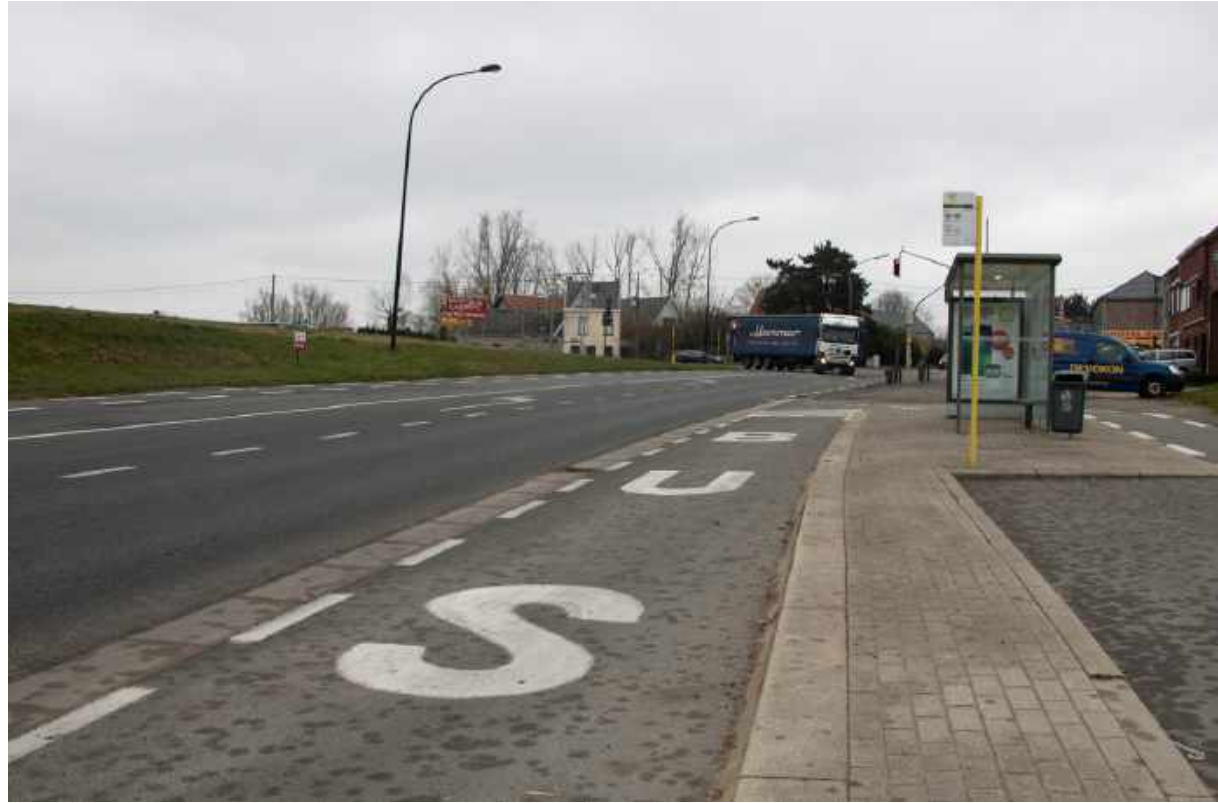
Halteinfrastructuur op de bestaande N60
