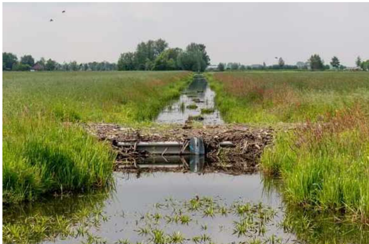
Stuwen en dammetjes voor vertraagde afvoer van bronwater.
