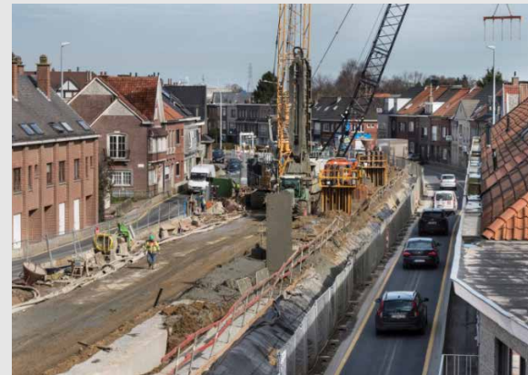
Tunnel in open bouwput doorheen een kern tijdens constructiefase, R41, Aalst.
