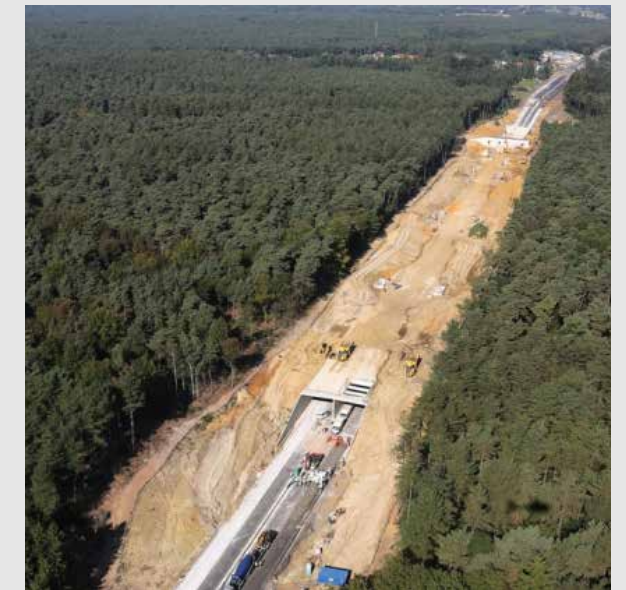
Invloed van tunnel in open bouwput op natuur tijdens constructiefase, Hoge Moutwunnel, Kasterlee.
